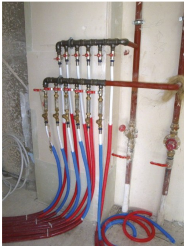
Fot. 6. Sposób rozprowadzenia instalacji c.o. wg systemu „rura w rurze” z rozdzielaczem usytuowanym na klatce schodowej.
