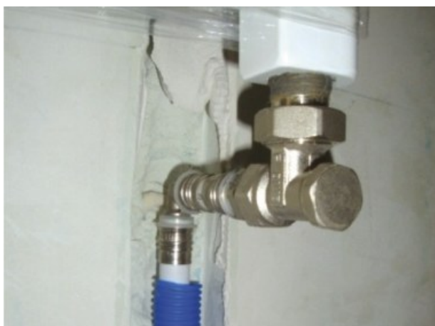
Fot. 7, 8. Grzejnik łazienkowy instalacji c.o. wodnej z widocznymi przewodami zasilającymi.
