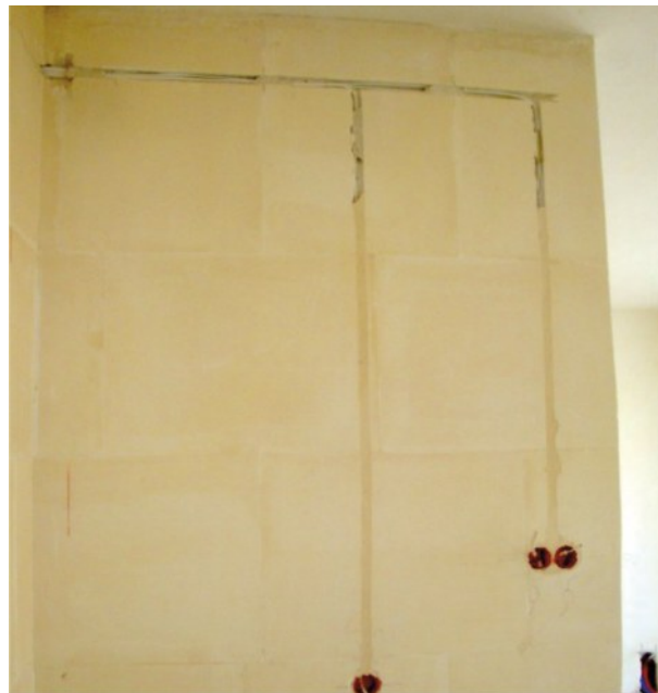
Fot. 2. Widok ściany z ułożoną instalacją elektryczną (bruzdy częściowo wypełnione zaprawą gipsową).
