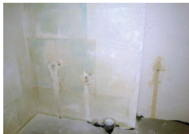
Fot. 3. Łazienka z wyprowadzonymi wewnątrz ściany podejściami wodnymi pod słuźkę i umywalkę oraz częściowo wykonanym podejściem kanalizacyjnym (na zewnątrz ściany).
