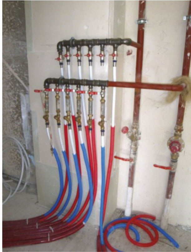
Fot. 6. Sposób rozprowadzenia instalacji c.o. wg systemu „rura w rurze” z rozdzielaczem usytuowanym na klatce schodowej.
