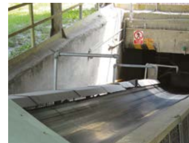
System tryskaczy wzdłuż przenośnika RHC115
