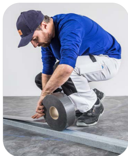
Fot. 2. Wszystkie profile mocowane do podłoża, ścian i stropów powinny zostać podklejone uszczelniającą taśmą akustyczną.
